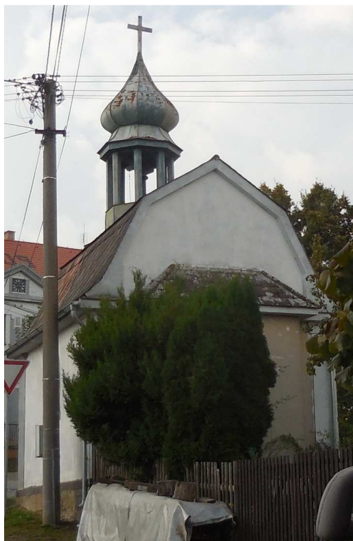
Celkový pohled na východní fasádu kaple
