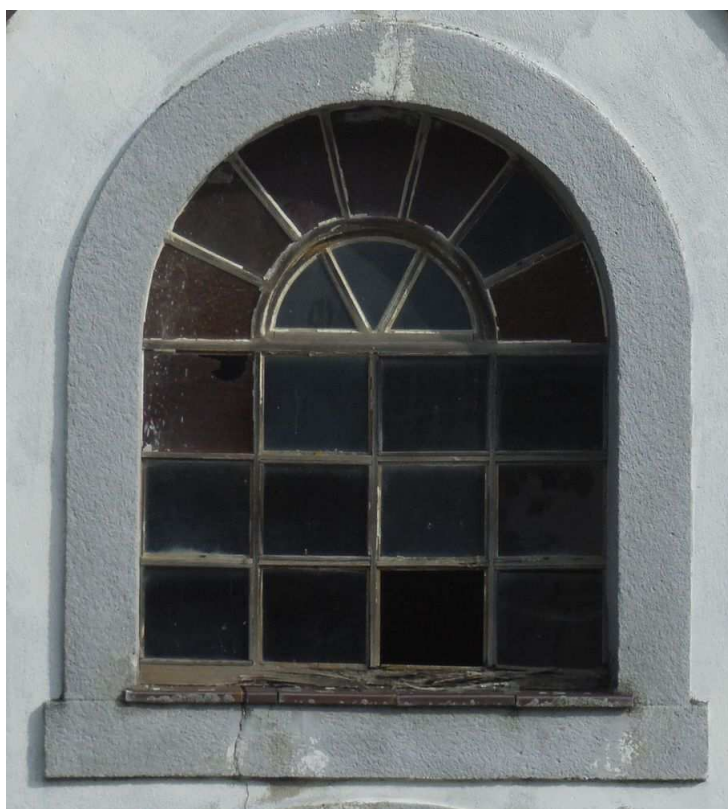
Okno – západní fasáda
