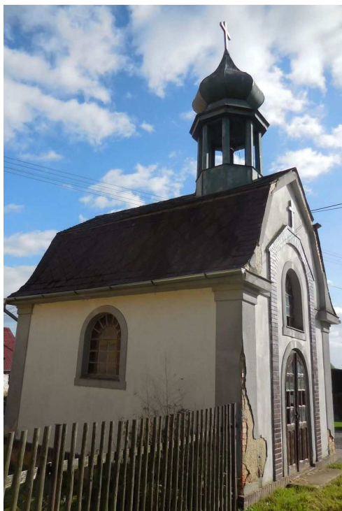
Celkový pohled na severní fasádu kaple
