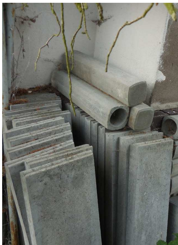
Uskladněný materiál na východní straně - odstranit
